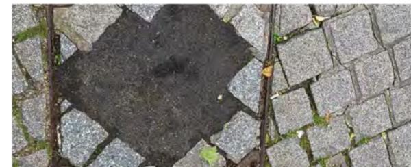
Temporäre Lösung für Schlaglöcher: Aus Gründen der Verkehrssicherung werden defekte Natursteinplatten und Pflastersteine aufgenommen. Entstehende Lücken werden mit Asphalt provisorisch ver4schlossen, weil das Natursteinmaterial nicht mehr zur Verfügung steht und eine umfassende Reparatur unverhältnismäßig wäre.
