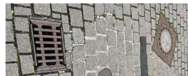
Defekte in der Oberfläche: Beschädigungen (offene Fugen) führen zu einem ungehinderten Wasserabfluss (Wasser kann in den Untergrund gelangen).
