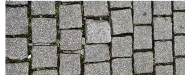
Unebene Pflastersteine: Beschädigte Fugen lassen das Unkraut wachsen. Offene Fugen führen dazu, dass der Halt der Pflastersteine nicht mehr gegeben ist und somit diese anfangen sich zu lösen.
