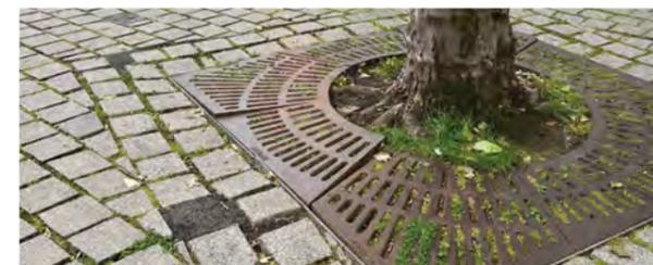
Schäden durch Baumwurzeln: Da die Baumscheiben zu klein dimensioniert sind, haben die aufwachsenden Baumwurzeln zu erheblichen Schäden an den umliegenden Strukturen geführt .
