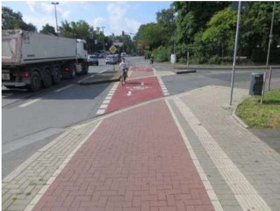
**Abbildung 45 Beispiel für einen roten Beistrich neben einer Radfahrerfurt**
